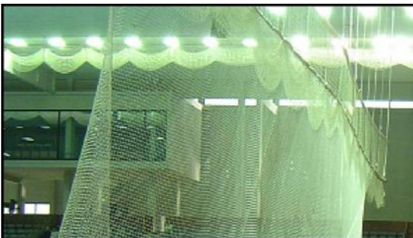
Filets de protection aux extrémités de la piste
